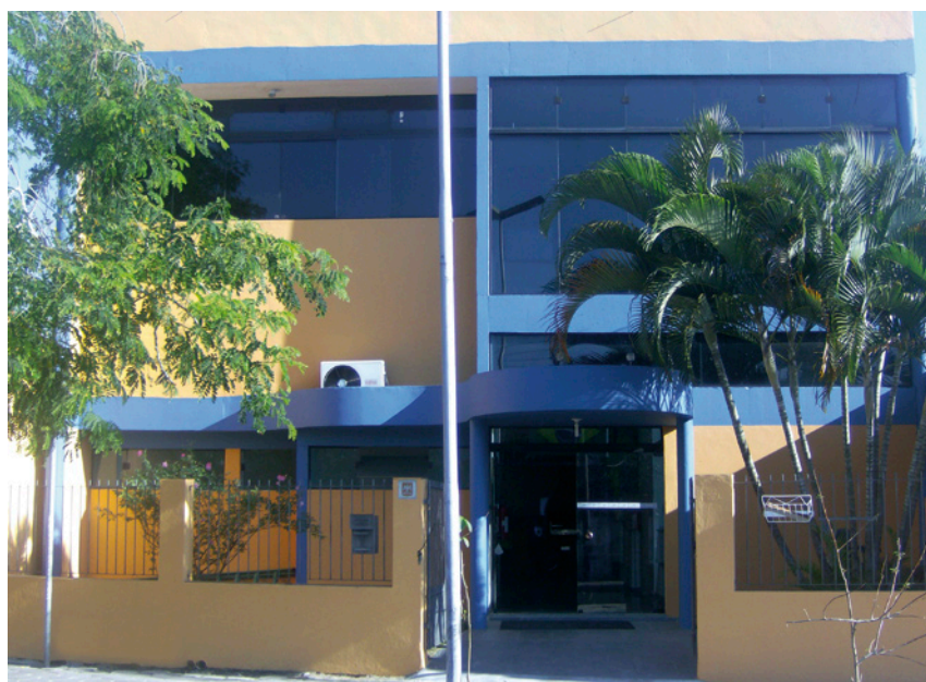
A fachada remodelada do prédio da sede
